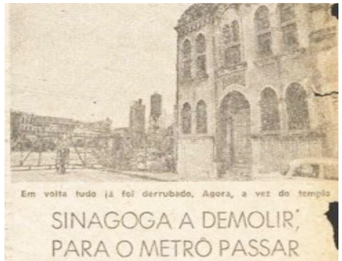
Foto 4: Notícia da demolição de sinagoga na Praça Onze. Jornal OGLOBO, 1974.
